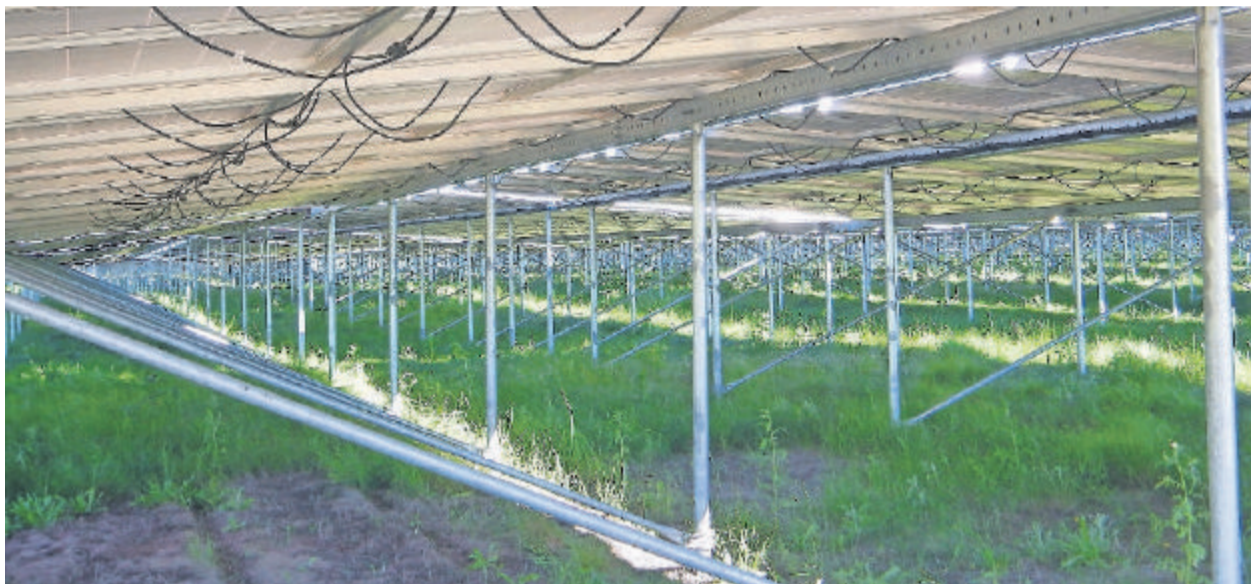
Die Pfähle, auf denen die Solarpanels montiert sind, wurden – ähnlich wie Slalom-Stangen im Schnee – ohne Betonfundament direkt in den Boden geschraubt. So bleibt nach dem Abbau nichts zurück.
